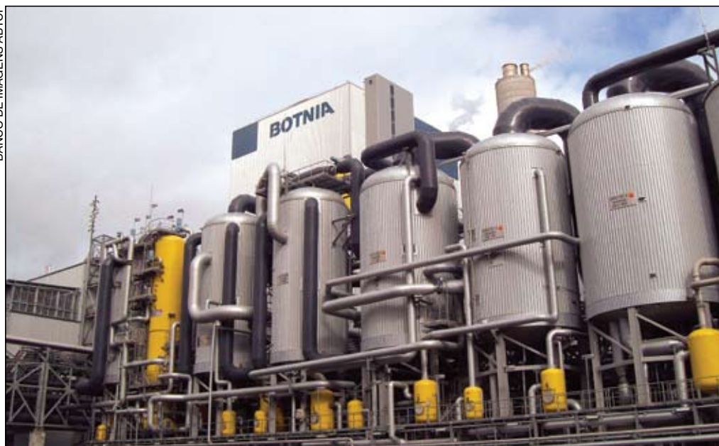
Para a construção da planta da Botnia foram utilizados praticamente os mesmos fornecedores que trabalham com o Brasil e a Finlândia
